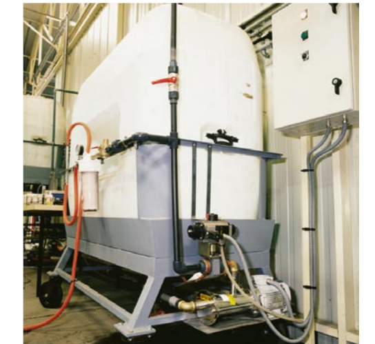
Насос Компакт M22000C4 в процессе заполнения (загрузки) установки соленой воды
