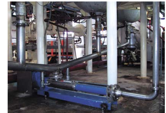
Насос Импакт 251A12 в процессе переработки фруктов и овощей. Транспортировка двойного концентрата помидоров: откачка из пастеризованных танков к буферным танкам
