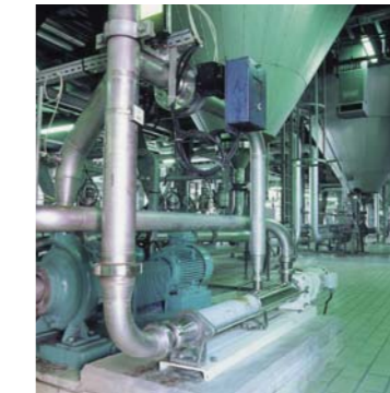
Насос Импакт 131A12 в процессе приготовления кормов для животных. Транспортировка и инъекция ингредиентов (масел, патоки, ферментов).
